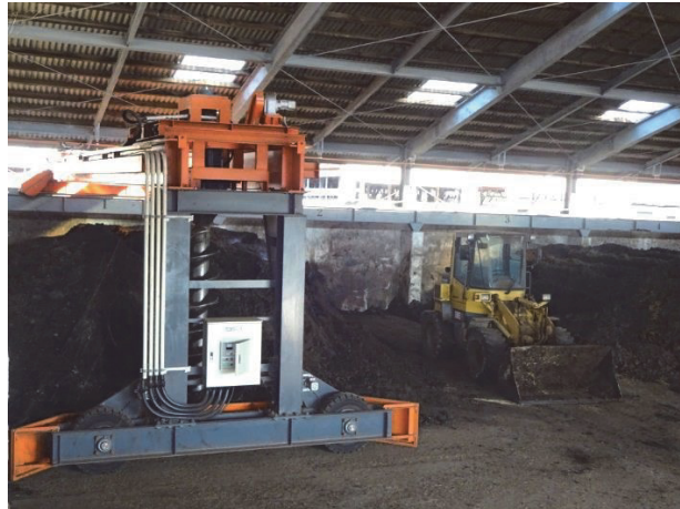
写真3 畜産クラスター事業で導入したスクリー式堆肥攪拌
